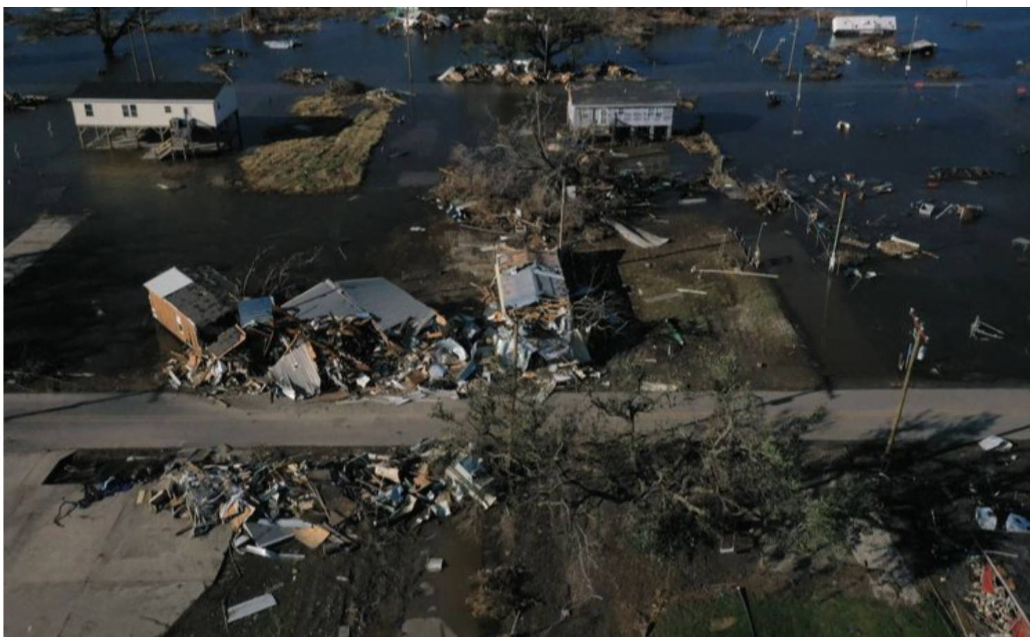
Casas destruidas tras el paso del huracán Delta en Cameron, Luisiana/reuters
