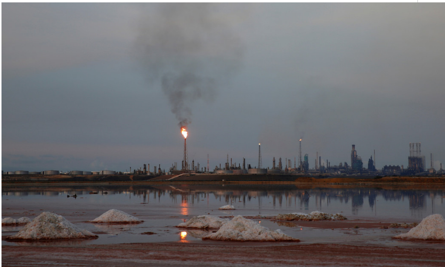
Vista general de la refinería Amuay en Punto Fijo, Venezuela, septiembre de 2016. Carlos Garcia Rawlins / Reuters
