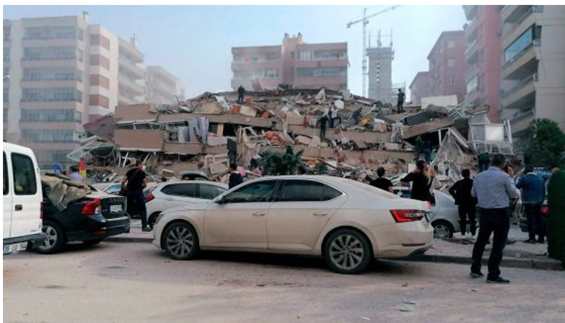
Edificaciones destruidas en Turquía, poco después del temblor. Foto: AFP
