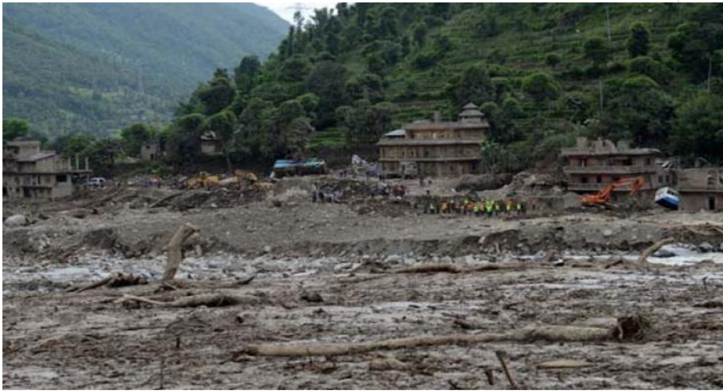
Deslizamiento de tierra
