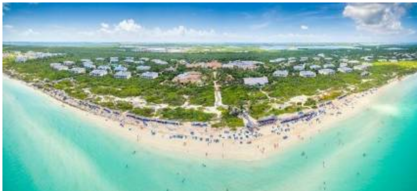
Finalizan nueva instalación hotelera en Cayo Santamaría, Villa Clara.
