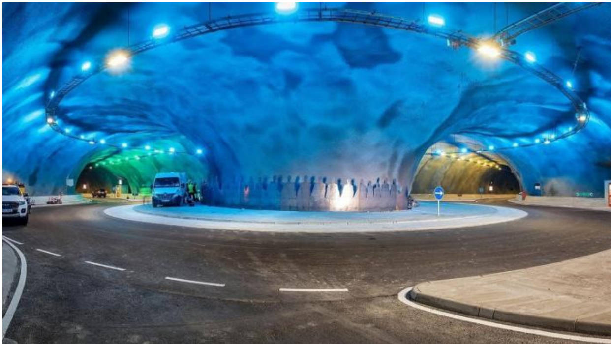
El primero de los túneles subacuáticos que formará parte de la mayor expansión de las infraestructuras de las islas Feroe. Foto: Tomada de Twitter
