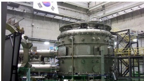
Una cisterna de helio del KSTAR, que forma parte del sistema de refrigeración del reactor. Foto: wikipedia.org.
