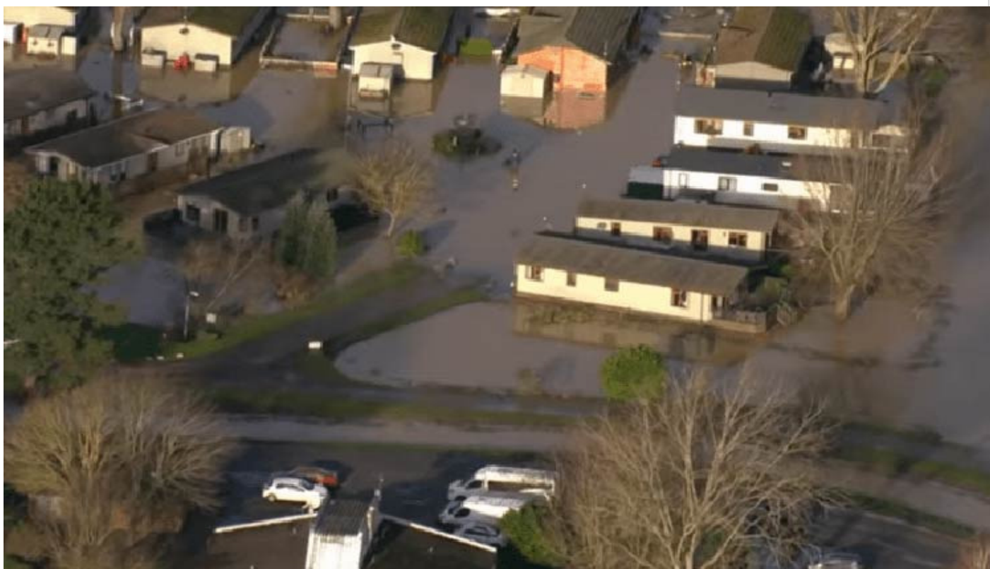
daños en Francia por tormenta Bella
