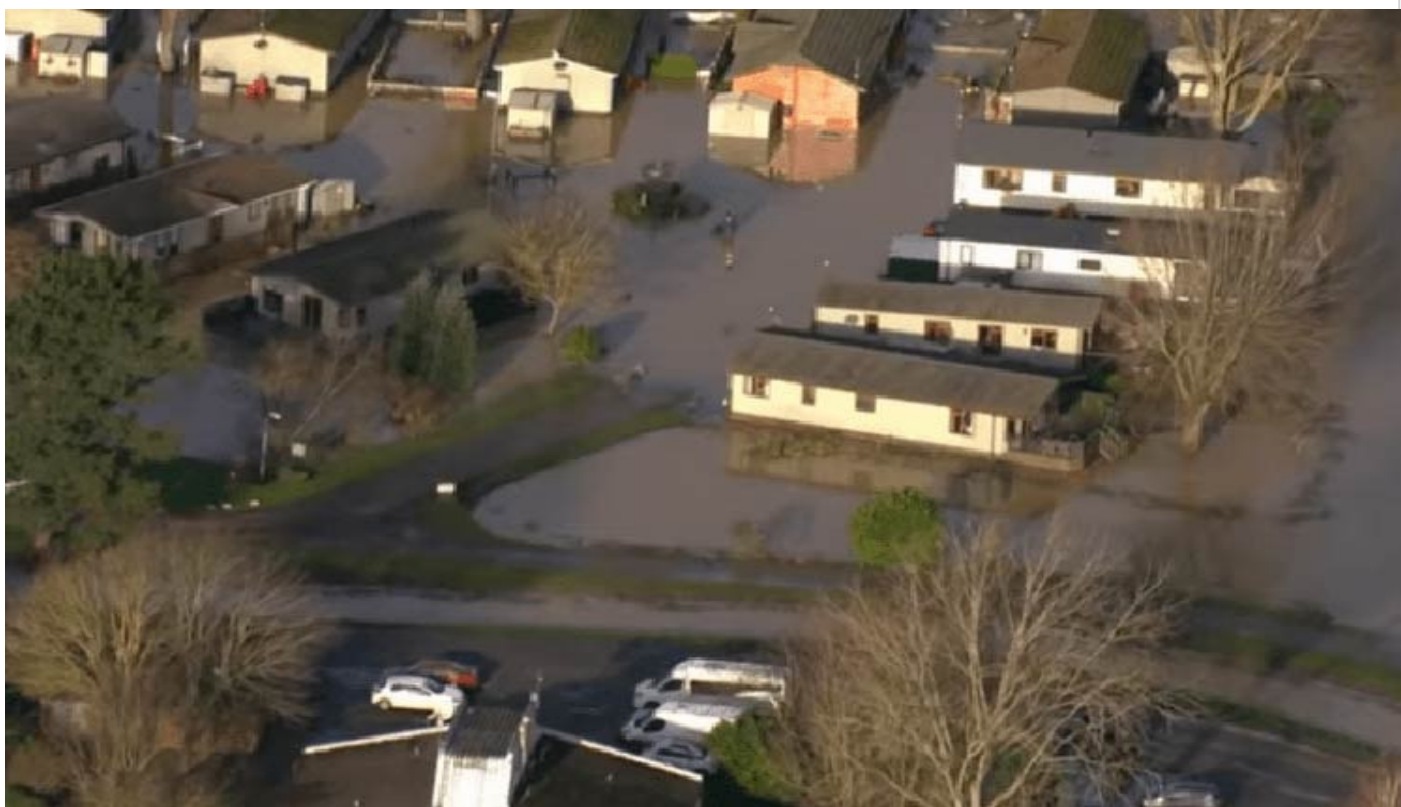
daños en Francia por tormenta Bella
