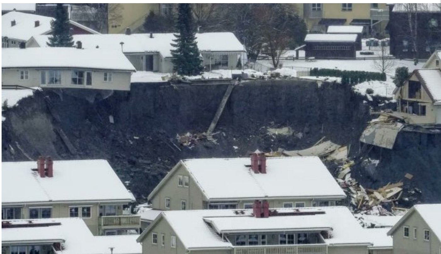
deslizamiento de tierras en Noruega
