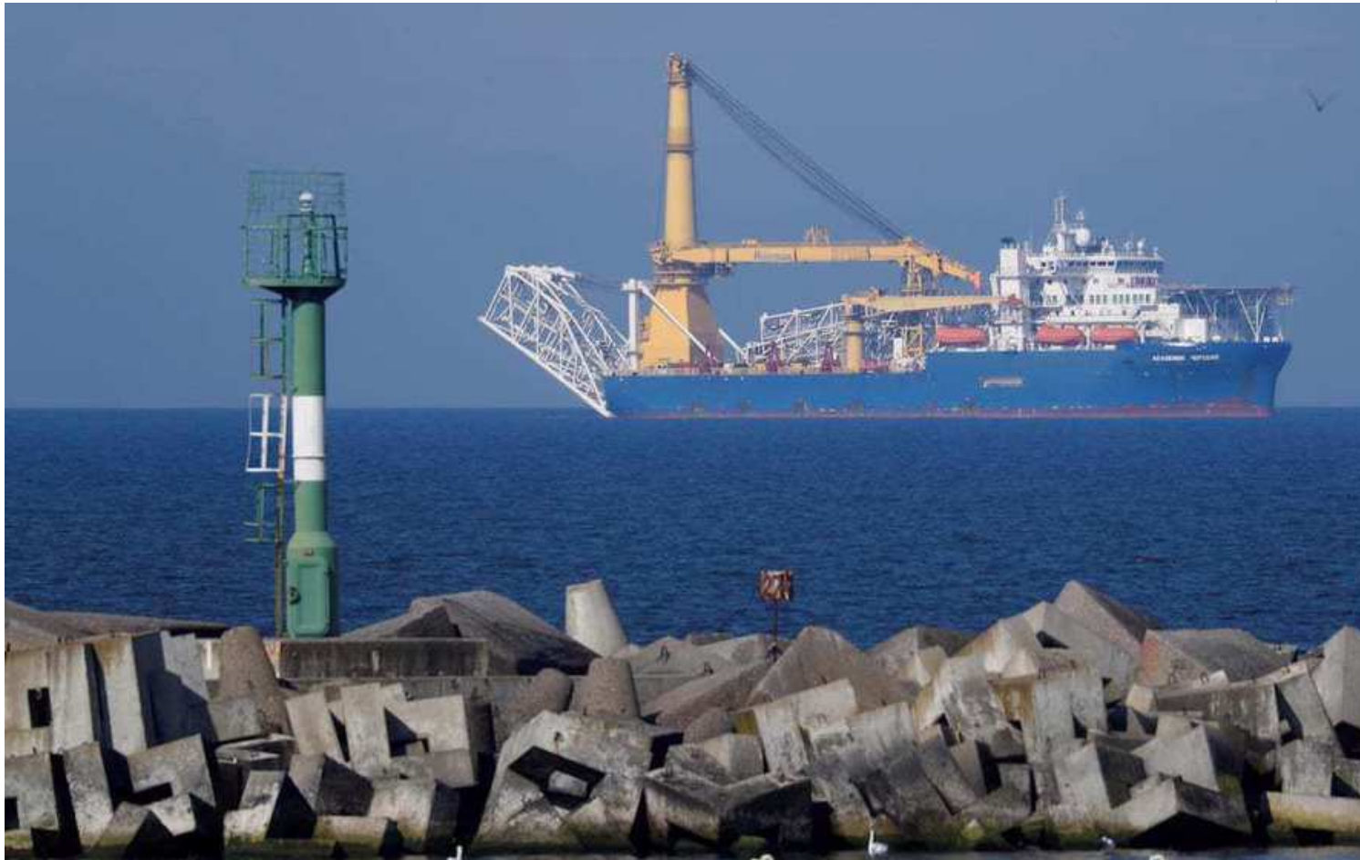
Construcción del gasoducto Nord Stream 2 (Foto: Reuters)
