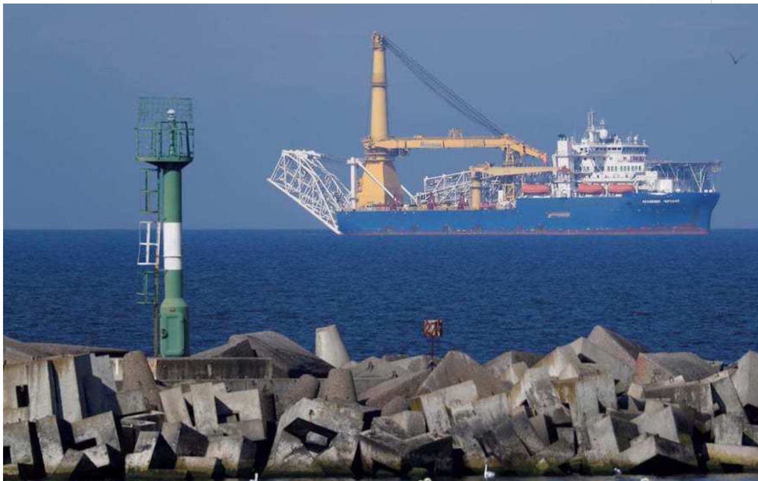
Construcción del gasoducto Nord Stream 2 (Foto: Reuters)
