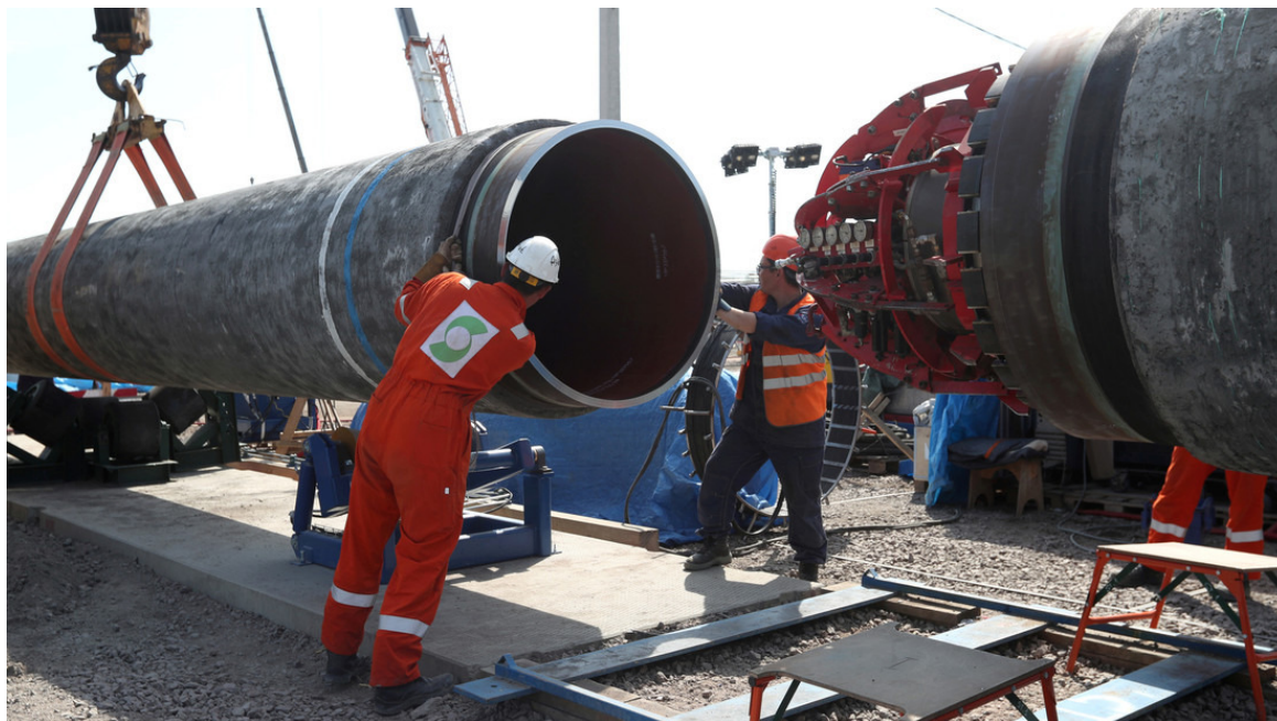
Reanudan construcción de gasoduto ruso.
