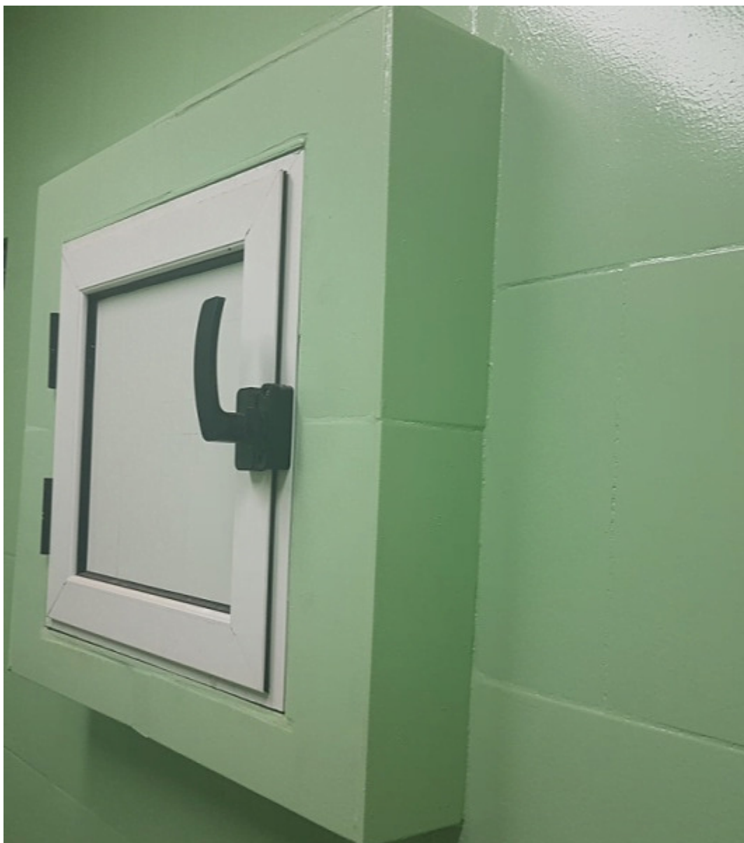
El laboratorio posee la pintura epóxica, acorde a las normas de seguridad. Foto de la autora.
