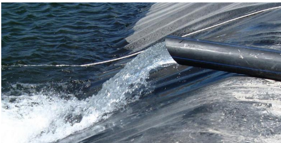
Empresa Aguas de La Habana acomete la obra Rincón-Cacahual, de rehabilitación de conductoras y redes de abasto. Foto: Archivo/RHC.
