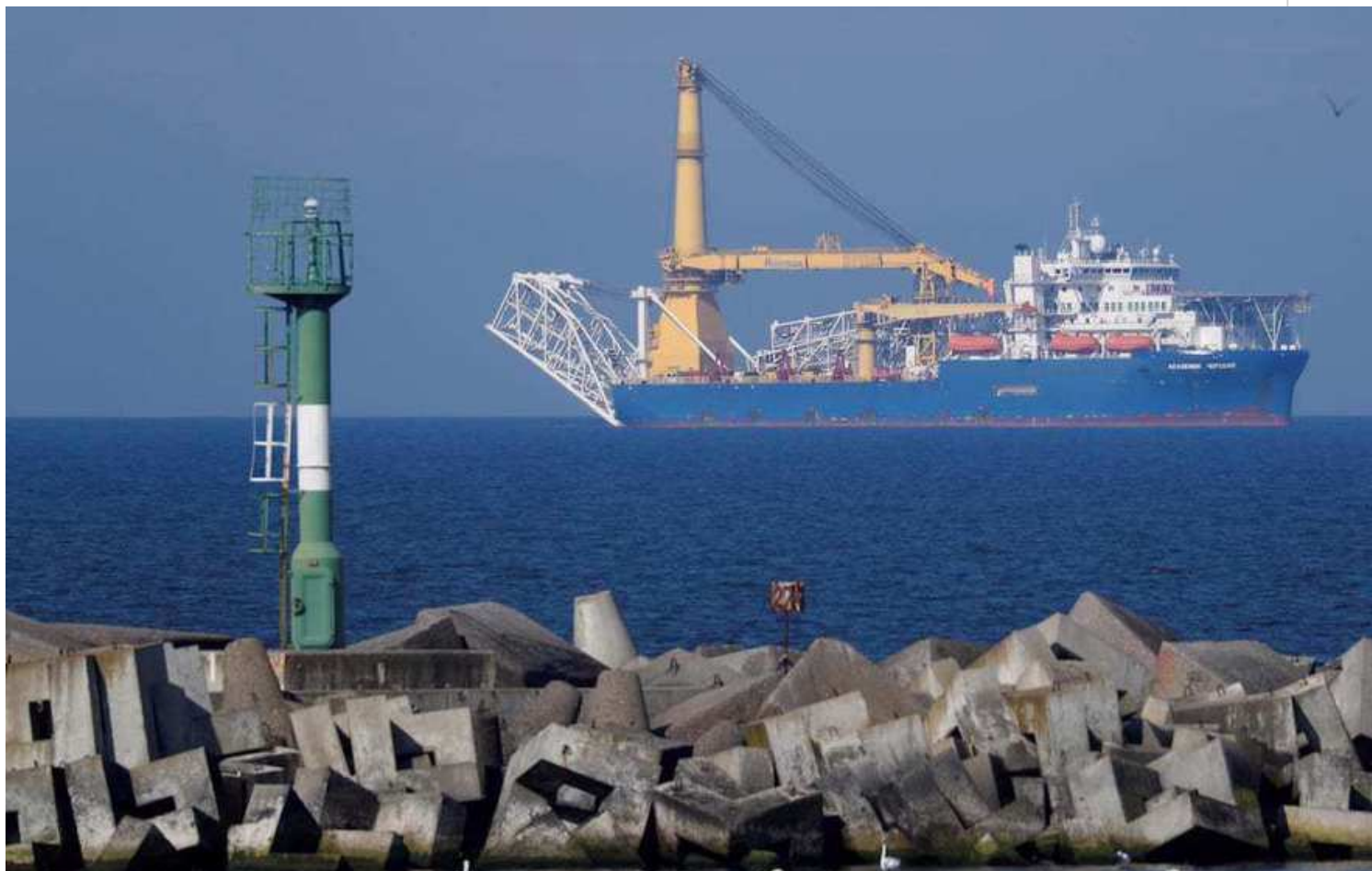
Construcción del gasoducto Nord Stream 2 (Foto: Reuters)
