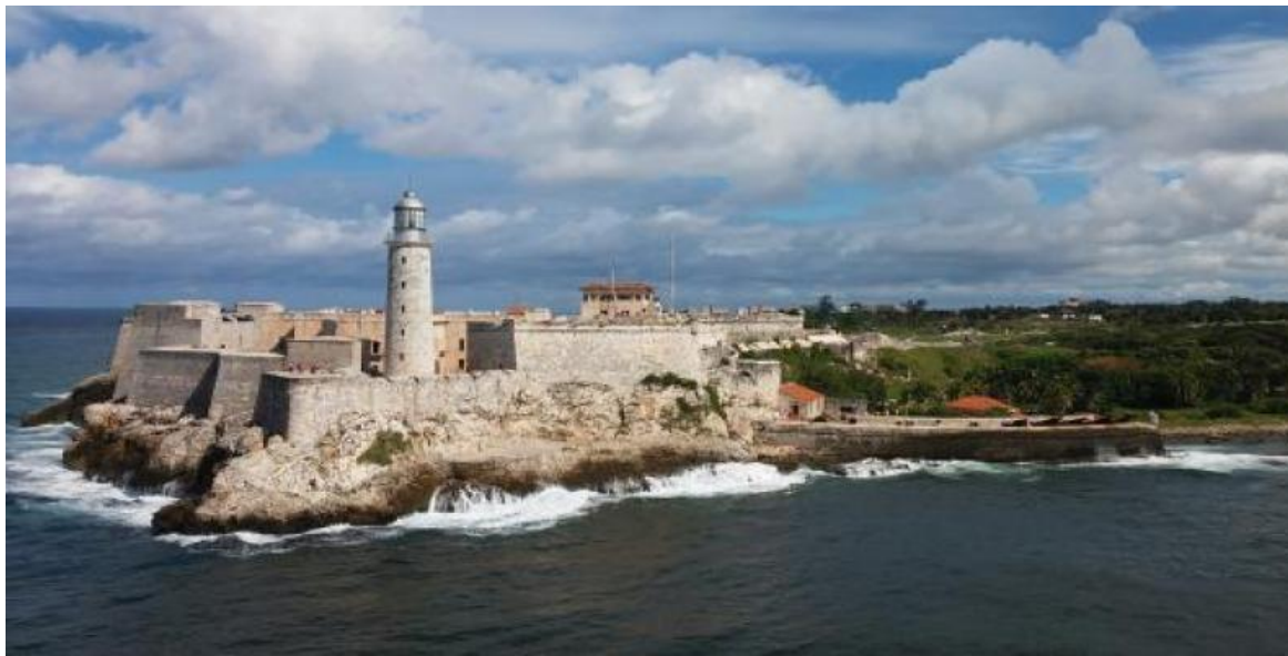
La rehabilitación general del Castillo del Morro San Pedro de la Roca en la bahía de Santiago de Cuba. Foto: Archivo/RHC.
