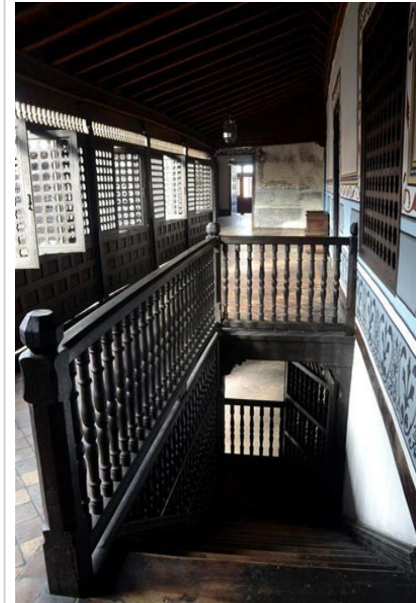
Escaleras casa Diiego Velázquez
