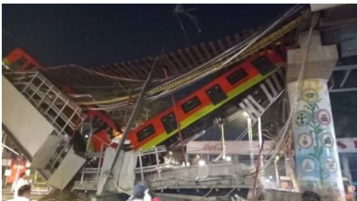
El puente se abrió y los vagones del tren cayeron
