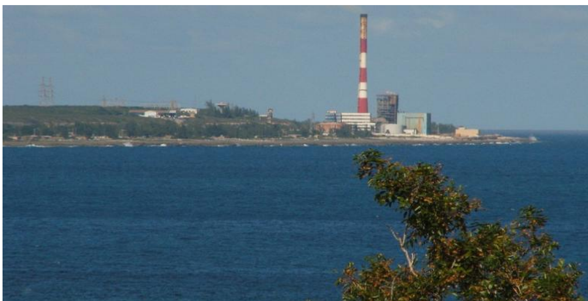
Central Termoeléctrica Antonio Guiteras de la provincia occidental de Matanzas. Foto: Archivo/RHC.
