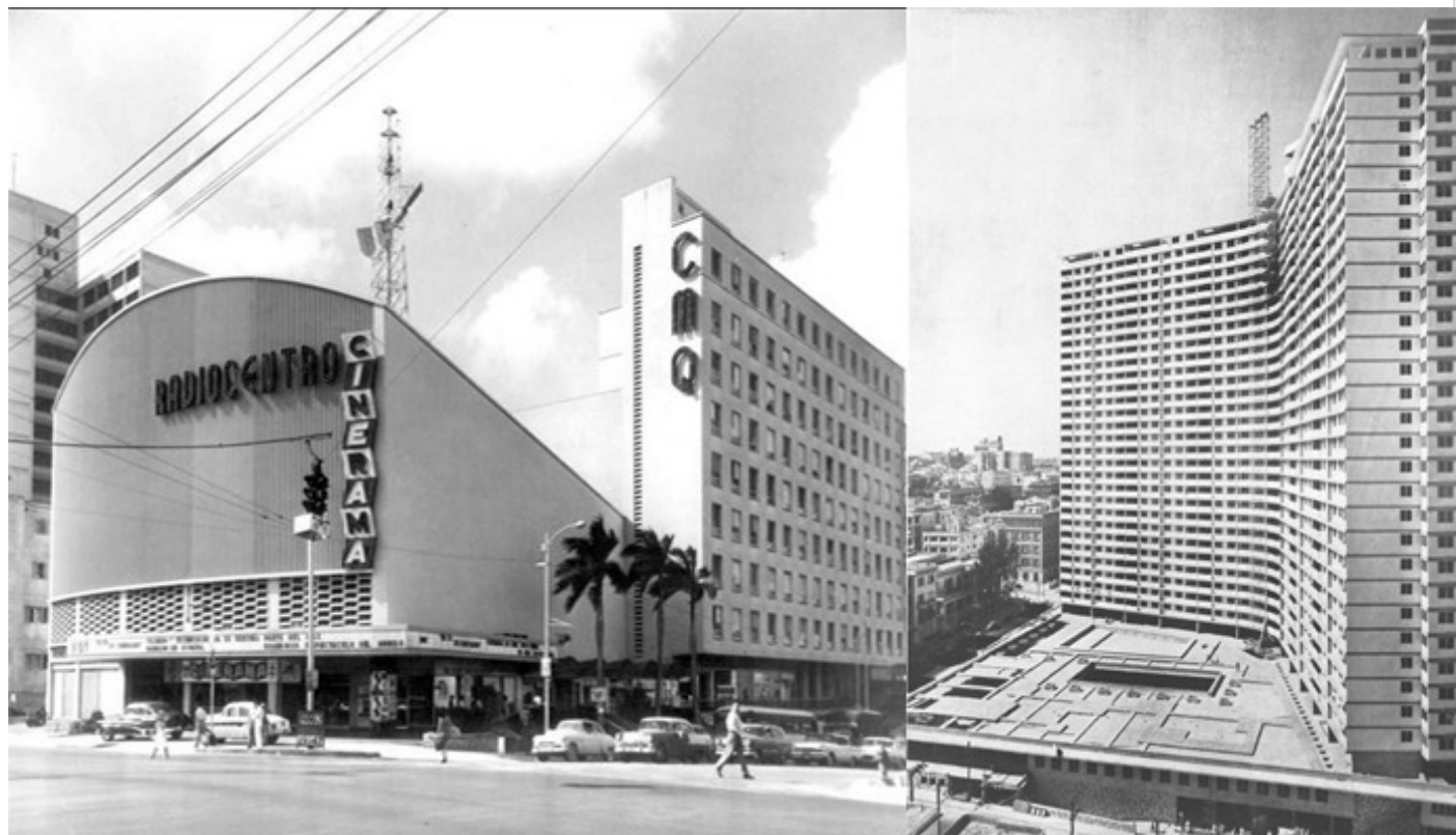
Edificios Radiocentro y Focsa
