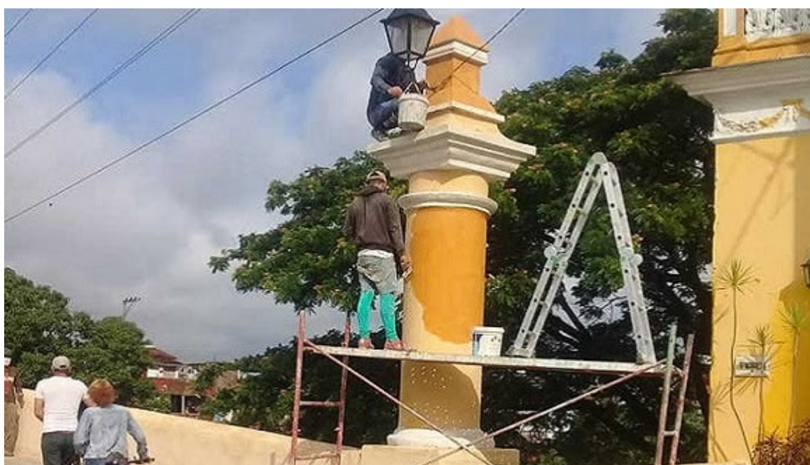
El puente sobre el Río Yayabo renace con nuevos colores. Foto: Facebook de Vitrales.
