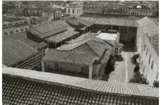
Techos de tejas de los distintos claustros del Convento de Santa Clara
