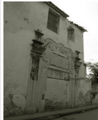
Pared exterior del Convento de Santa Clara
