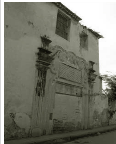
Pared exterior del Convento de Santa Clara
