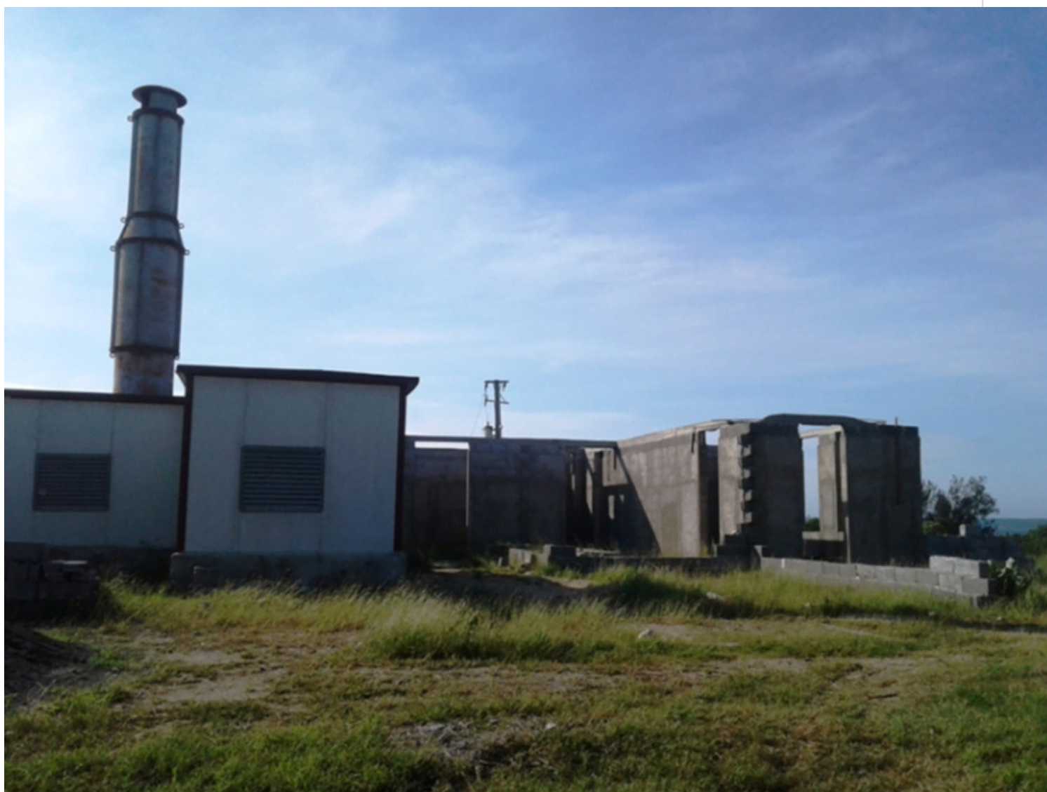
Avanza obra del incinerador del Cementerio Tomás Acea, de Cienfuegos. (Foto: Mireya Ojeda)
