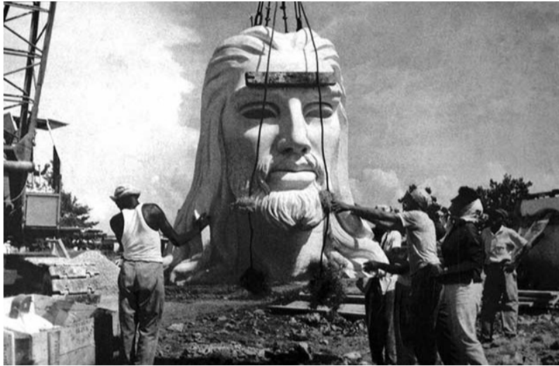
Montaje de la monumental obra
