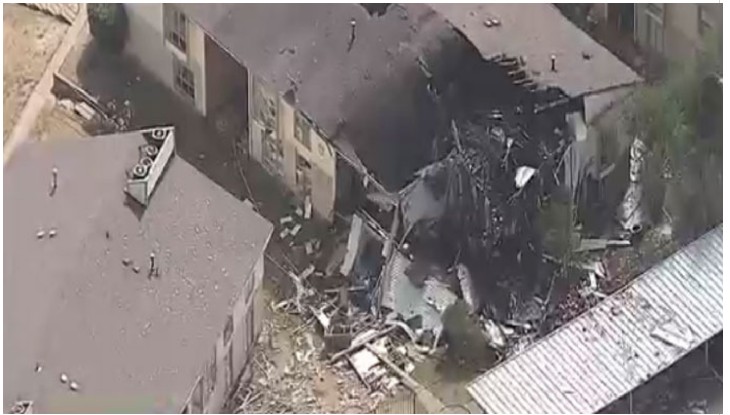
Explosión en un Complejo de edificios en Dallas
