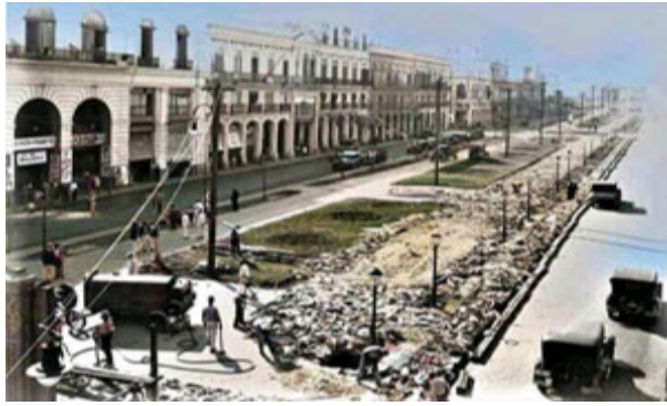
Reconstrucción del Paseo del Prado
