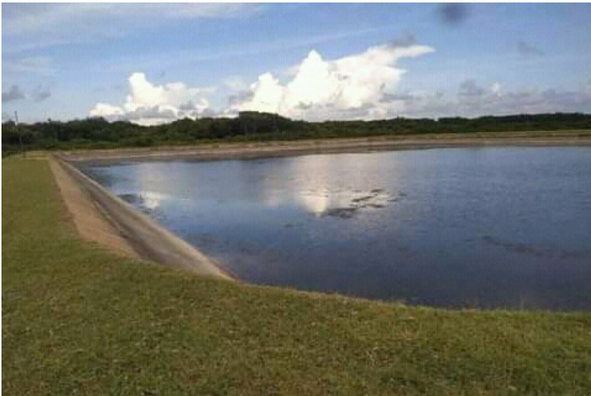
En la Planta Potabilizadora de Juraguá se acometen mejoras integrales. Foto-Mireya Ojeda
