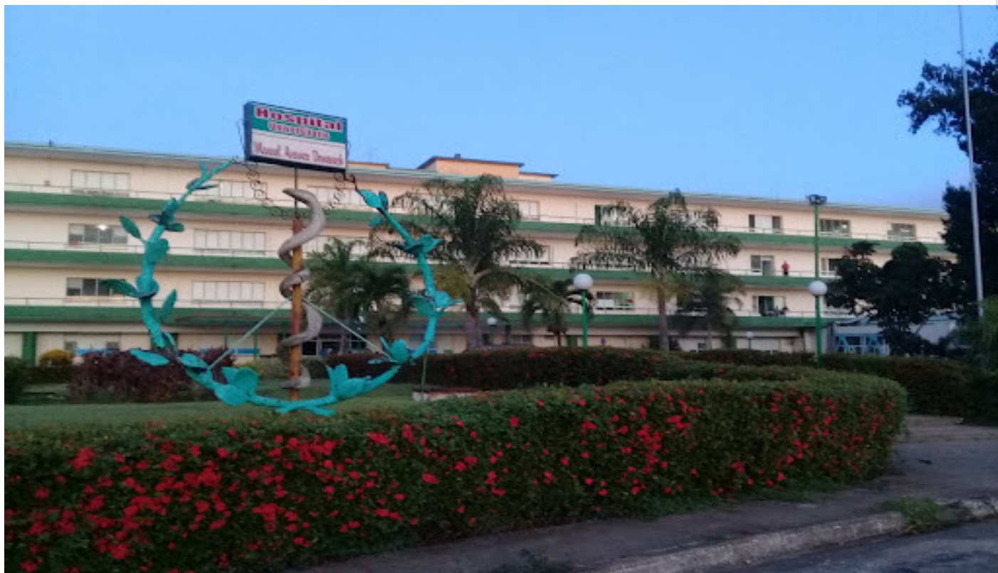
Hospital Manuel Ascunce en Camagüey
