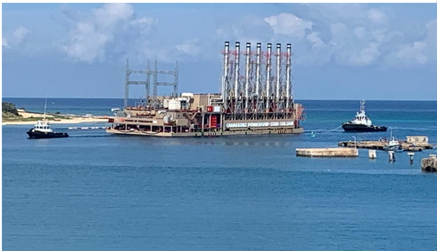
Central Eléctrica flotante
