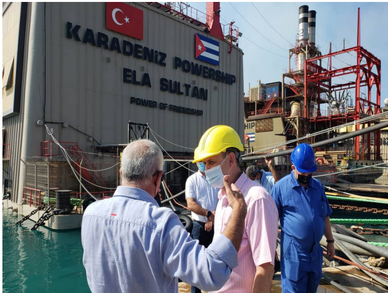
Central Eléctrica flotante
