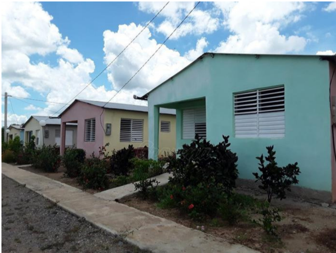
El polo de viviendas Blanca Rosa se edificó utilizando la técnica del mampuesto
