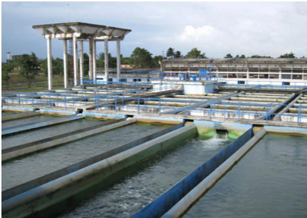
Rehabilitan planta potabilizadora de Camagüey
