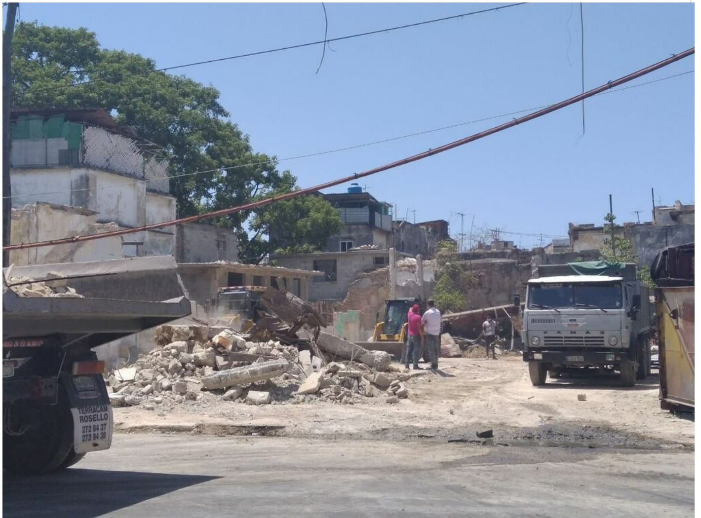
Alistan construcción de viviendas para familias damnificadas. Foto: Viani Pulido Coba
