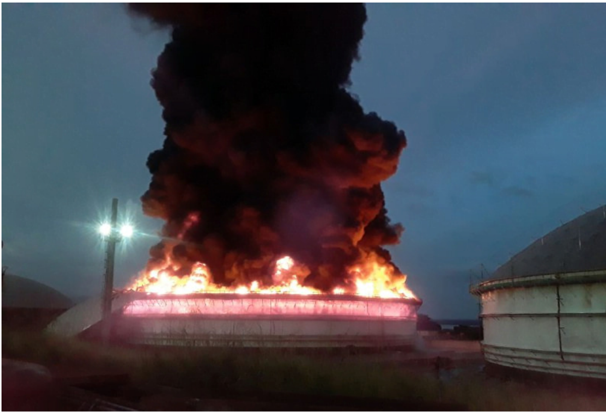
El fuego comenzó por el tanque 52, cuyo techo fue impactado por un rayo. Foto: ACN
