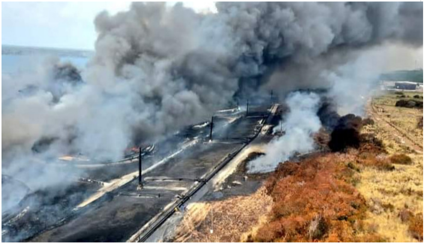
Incendio base supertanqueros de Matanzas, Cuba
