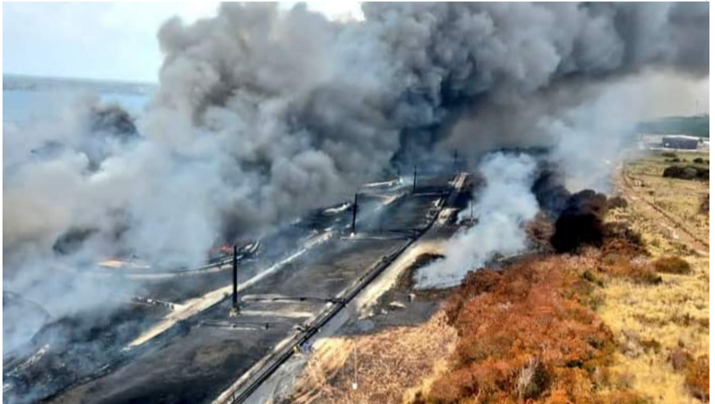
Incendio base de tanques de combustível de Matanzas, Cuba
