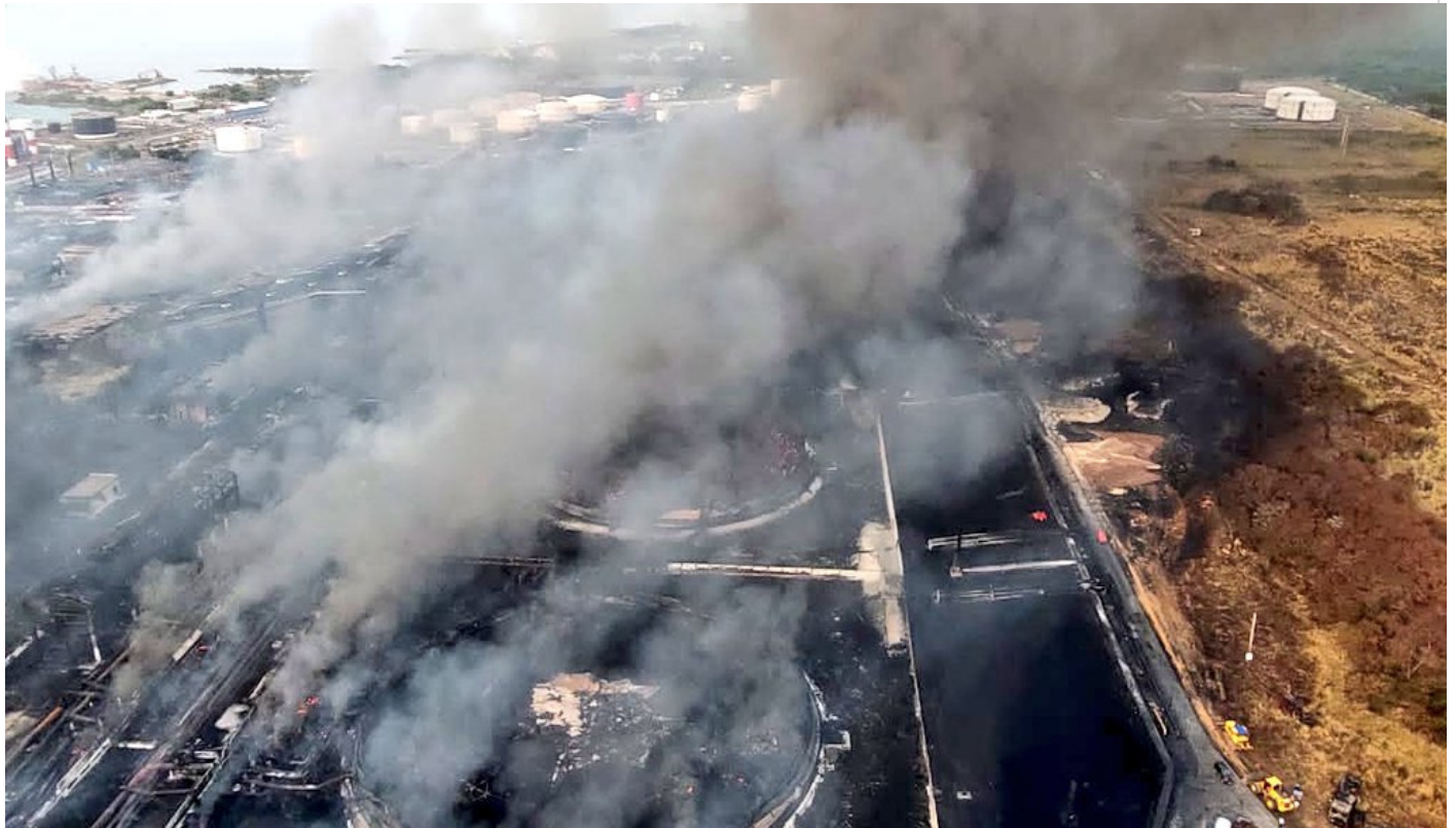
Petróleo derramado por incendio
