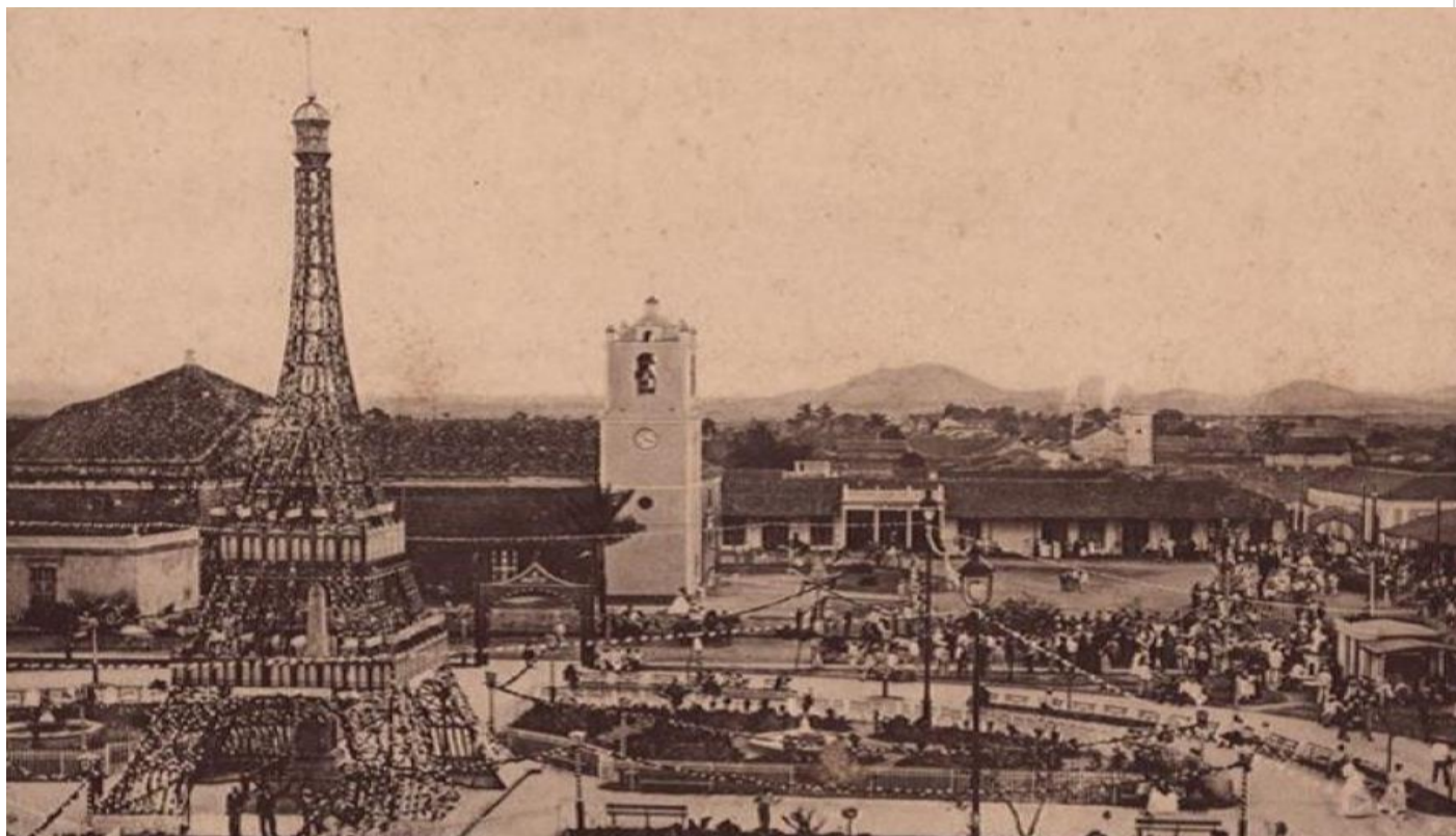
Replica de la Torre de Eifel en Santa Clara
