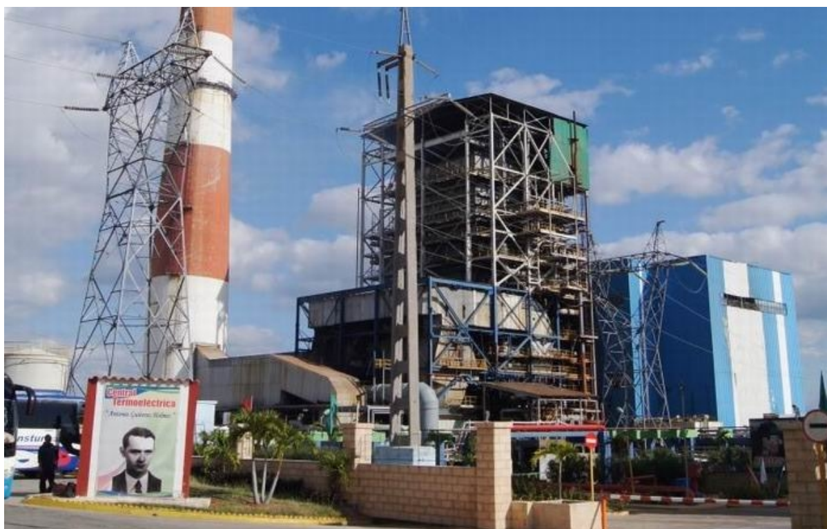
La Guiteras es la mayor y más eficiente termoeléctrica de Cuba. Foto: Archivo/RHC
