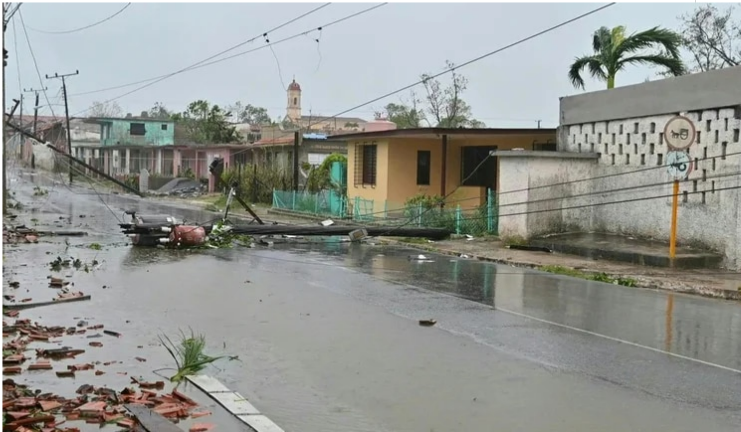
El huracán 'Ian' deja dos muertos y grandes daños materiales en Cuba
