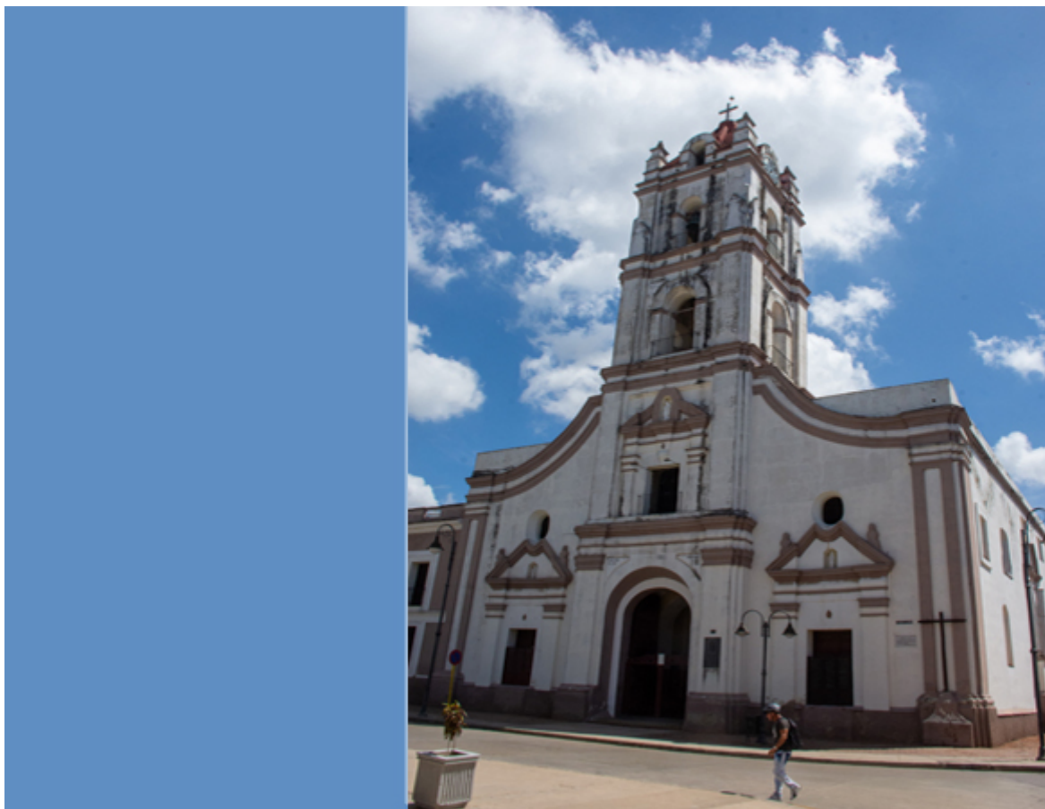
Iglesia de la Merced en Camagüey
