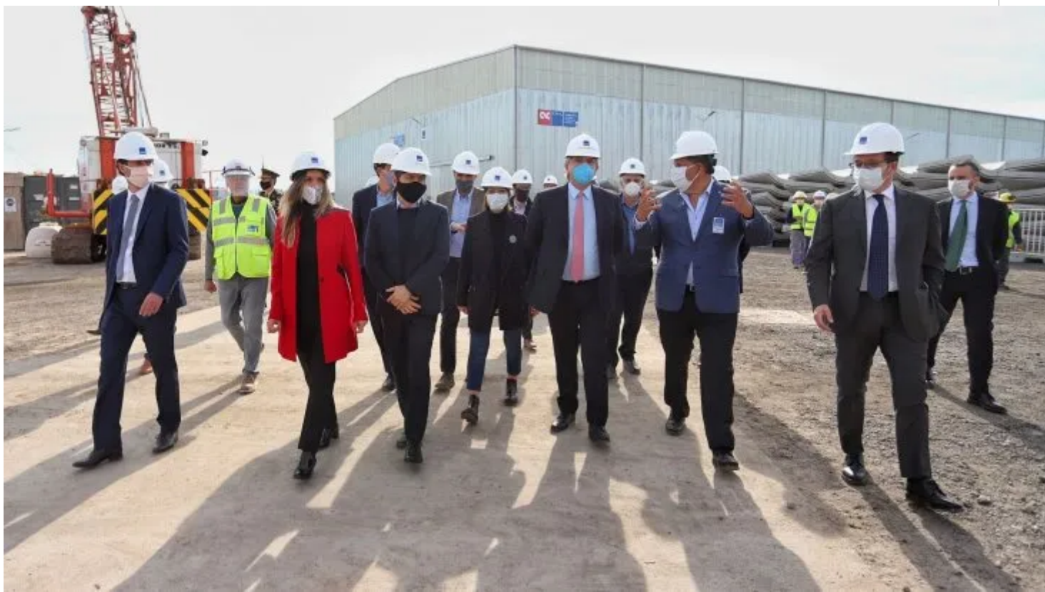
Alberto Fernandez a inauguré ce mardi la seconde ligne d'une station d'épuration d'eau à proximité de Buenos Aires.Photo: Aysa
