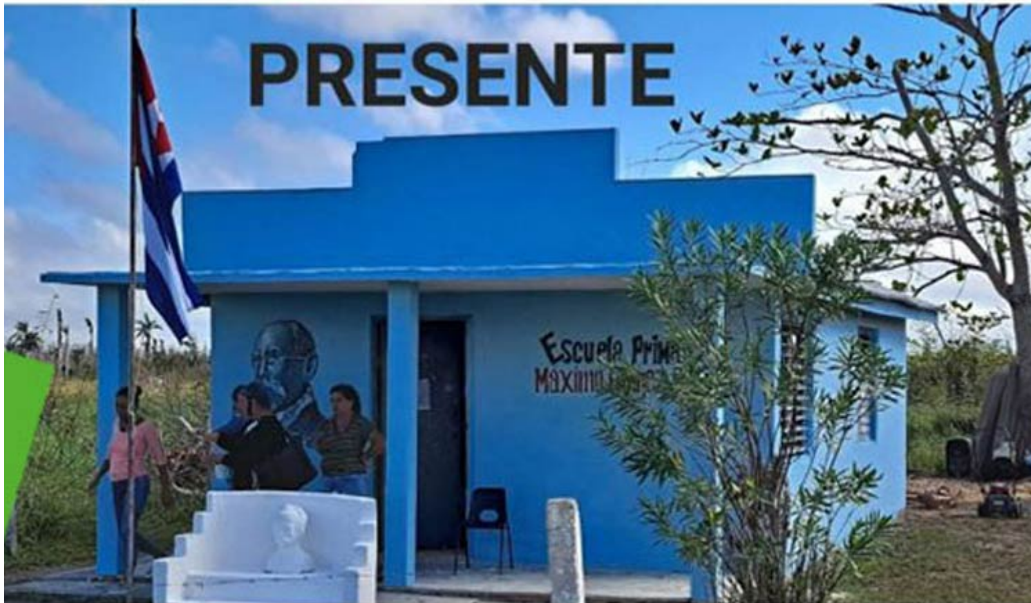
Une petite école rurale avant et après la réparation. Photo: Prensa Latina
