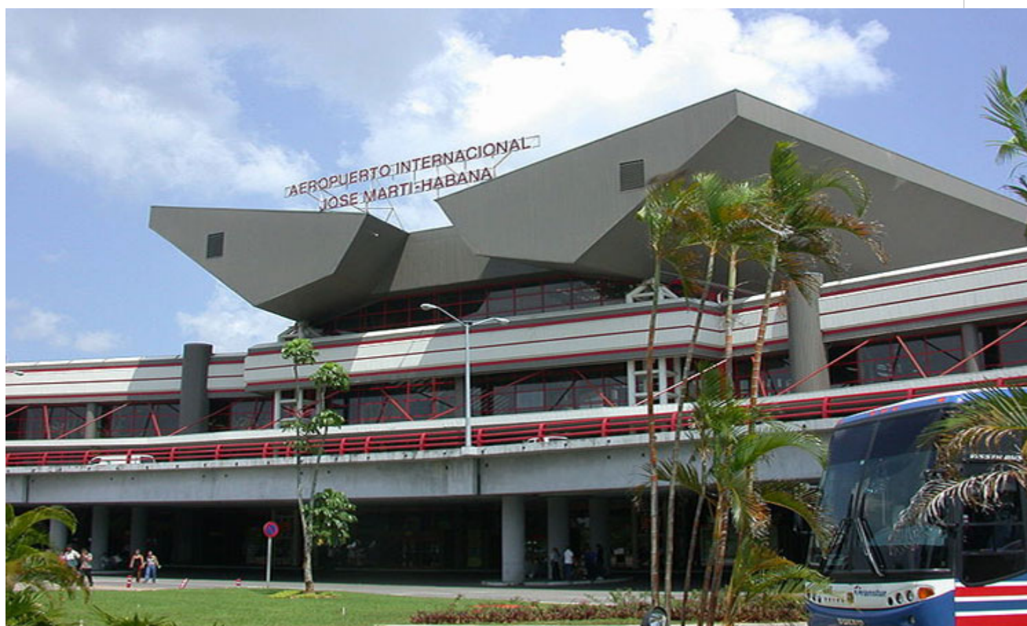
Aeropuerto Internacional José Martí
