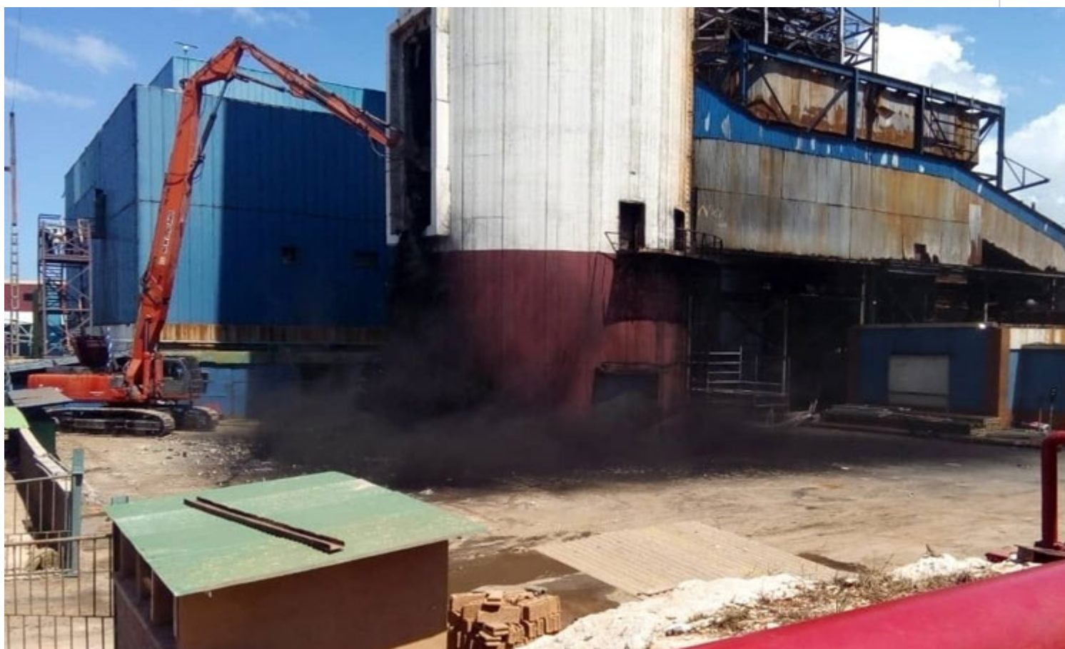
Aberto buraco na chaminé
