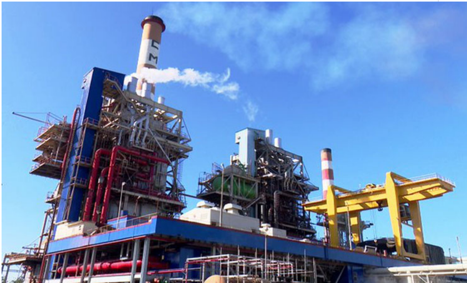
Termoeléctrica de Cienfuegos
