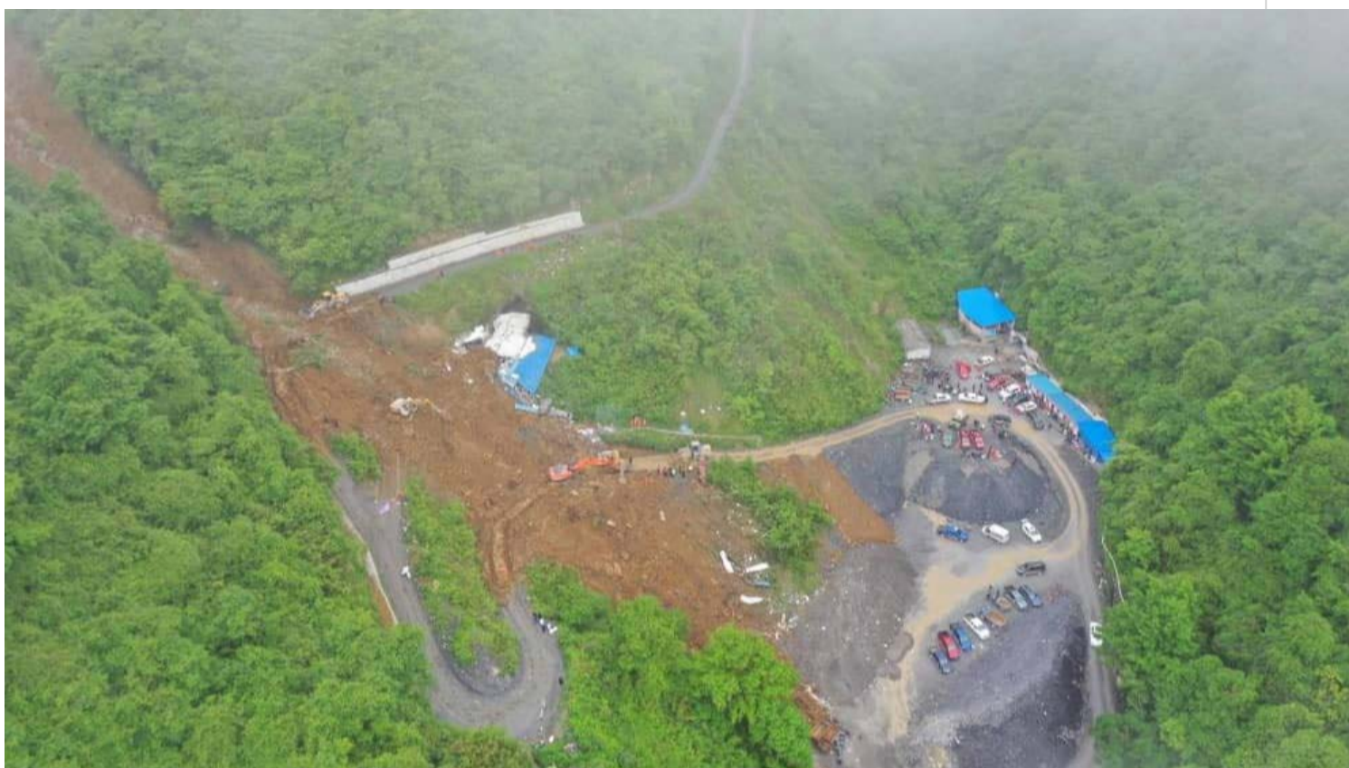
Deslizamiento de tierra en Sichuan.
