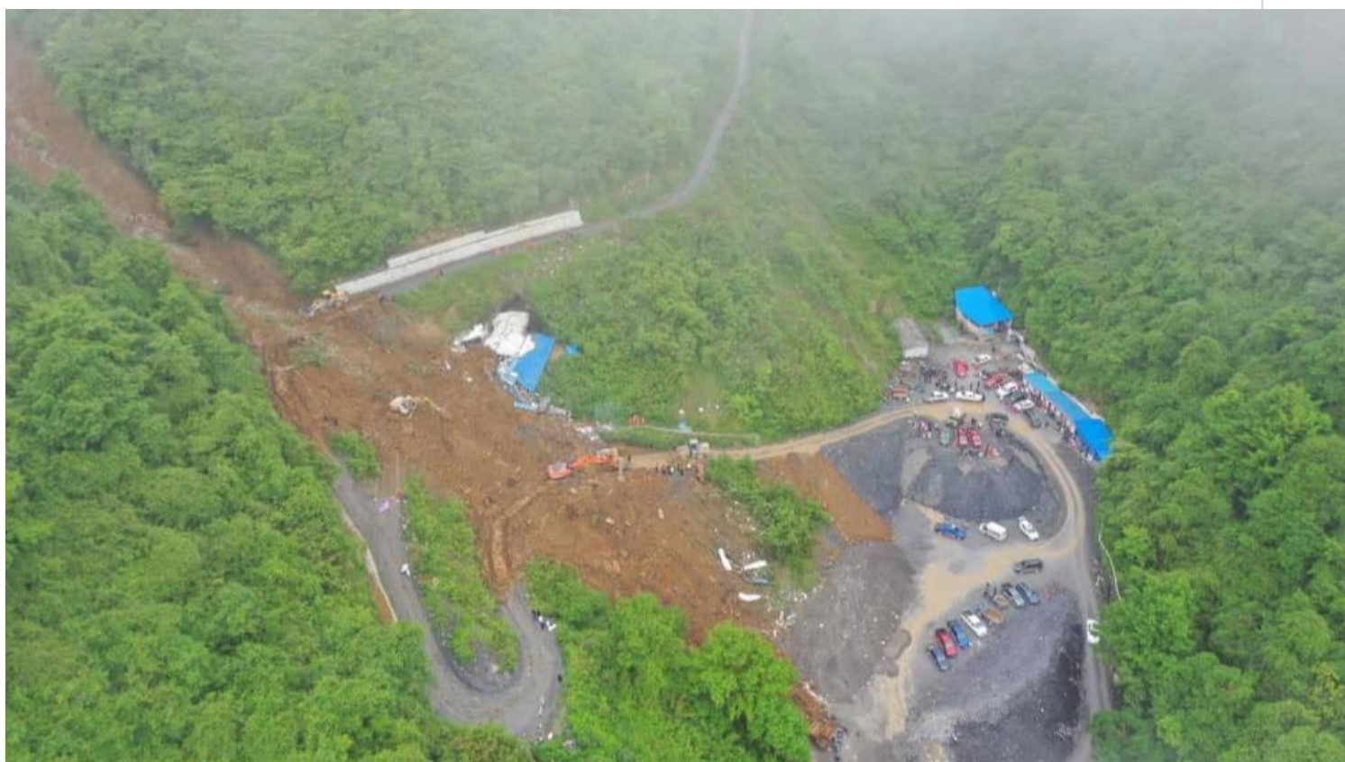
Deslizamiento de tierra en Sichuan.
