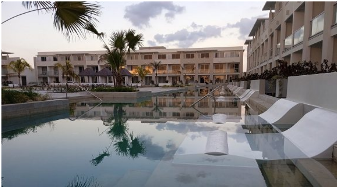
El Meliá Trinidad Península, que será inaugurado en octubre próximo, es una instalación autosuficiente. Foto: Karina Rodríguez/Cubadebate
