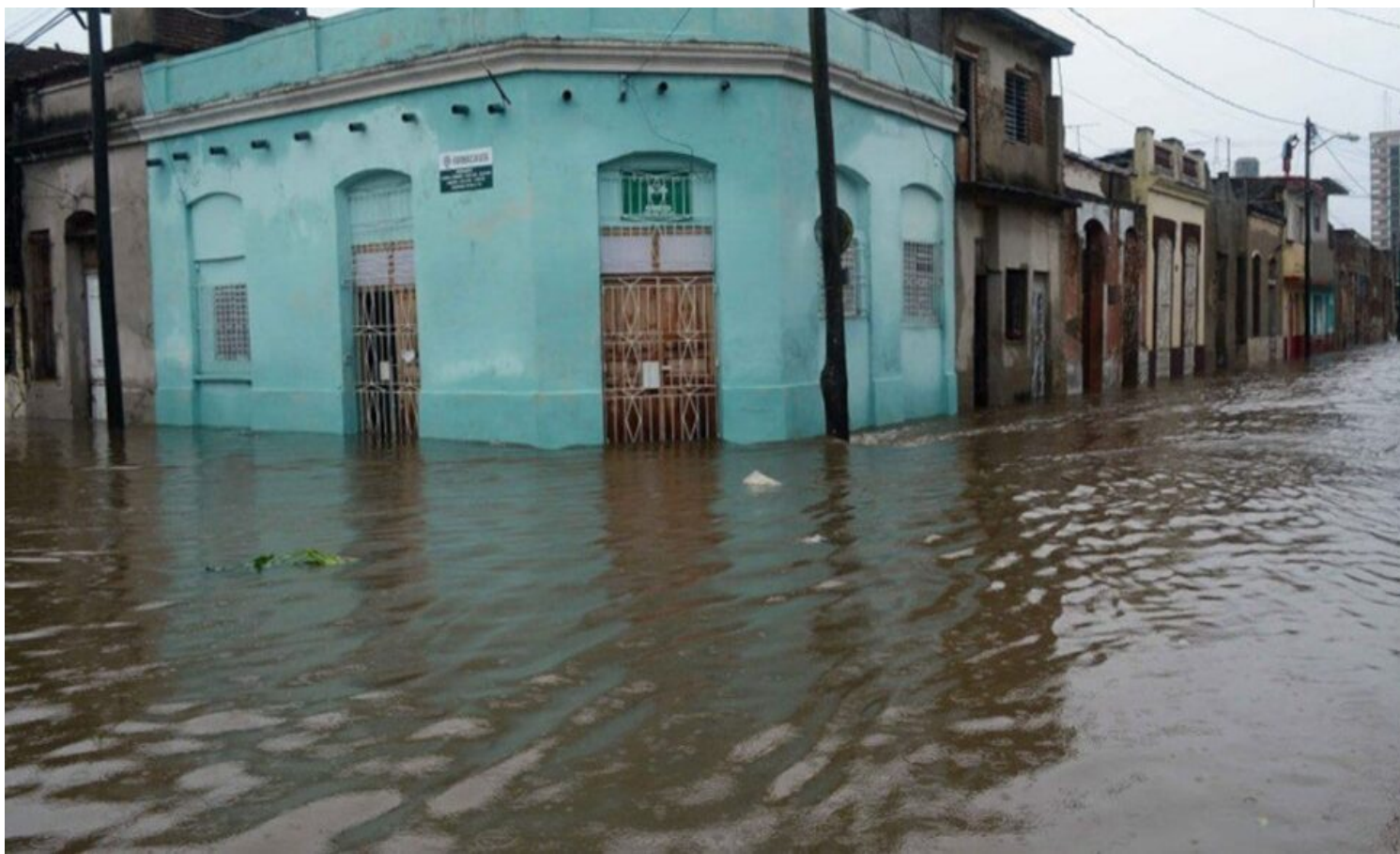
Viviendas afectadas por intensas lluvias
