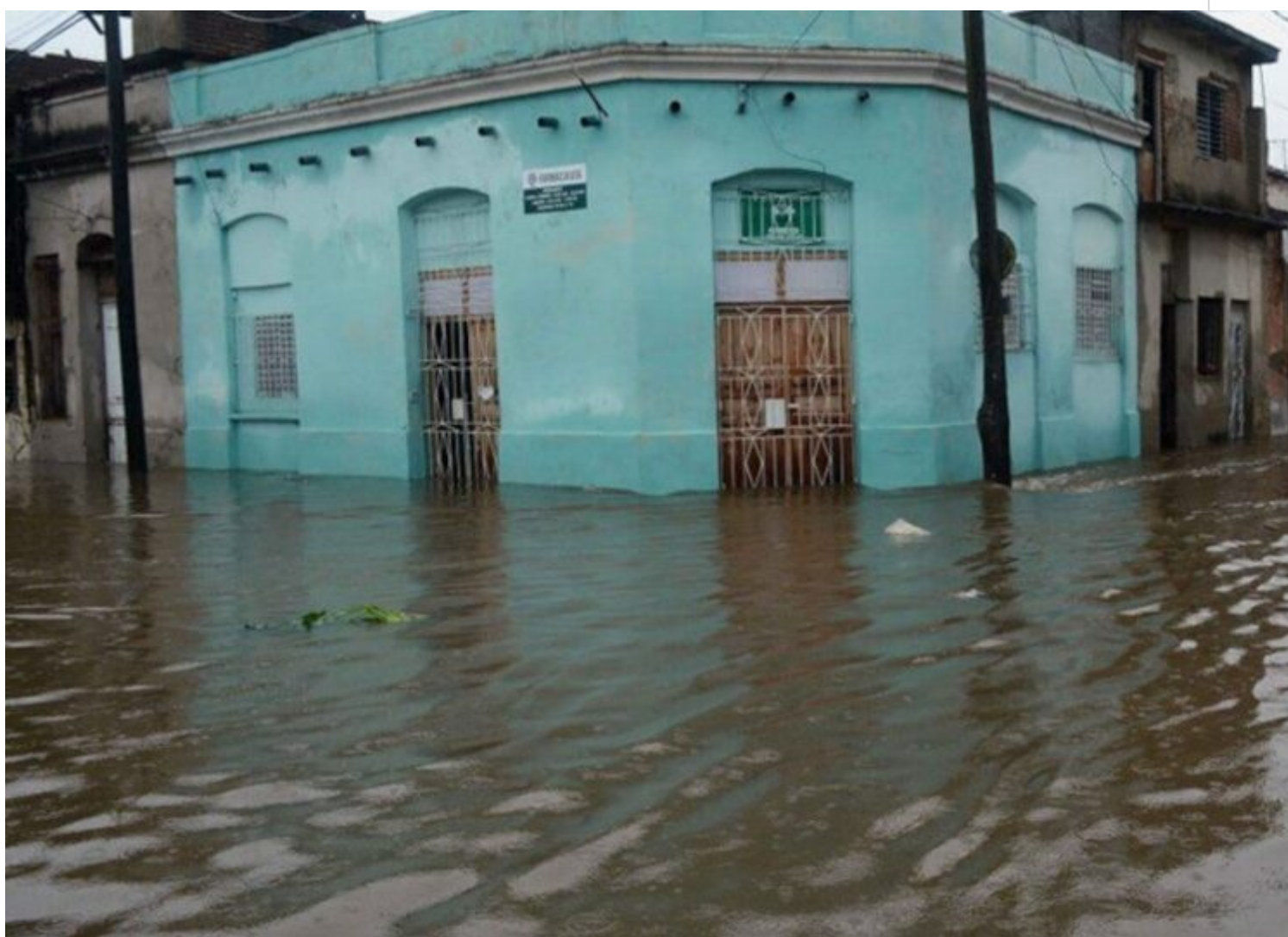
moradias danificadas pelas chuvas
