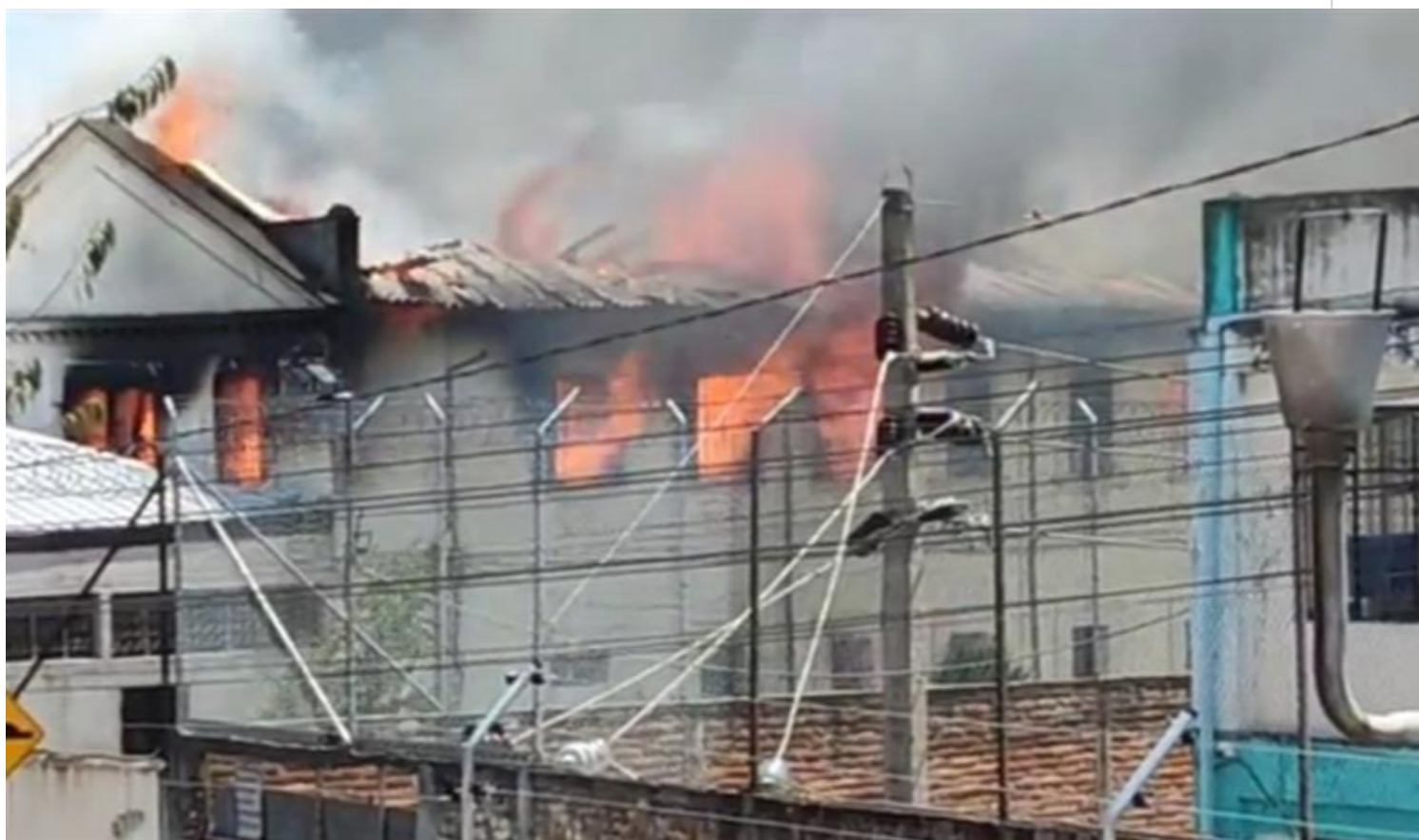
Centro de Adolescentes Infractores Virgilio Guerrero, en Quito.
