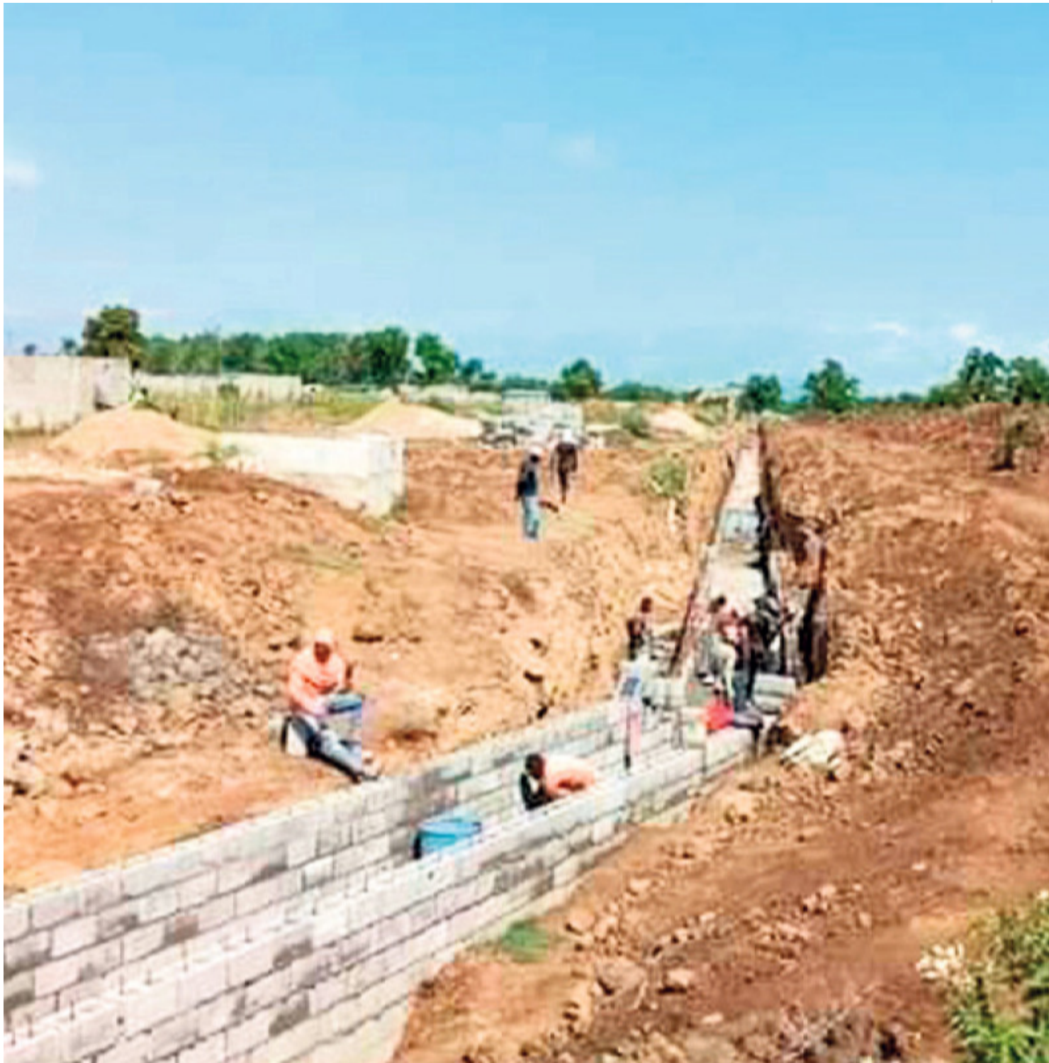
Construcción de un canal en Haití para desviar aguas del río Masacre.
